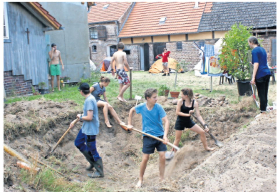
Die Schüler beim Ausheben der Grube für den Tank.
